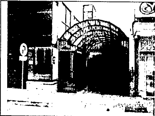
Fotografía No 3. Acceso al edificio
